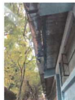
Foto 4: Sustrución de canales para evacuación de aguas pluviales Material: lamina galvanizada Tipo: lisa, Anclaje: canal sostenido por pescantes metálicos.
