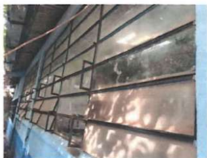
Foto 3: Sustrución de ventanas; sistema de apertura: Corredizas, Perfiles color blanco estandar, Material del marco: PVC Material de la ventana: Vidrio, sellado perimetral.
