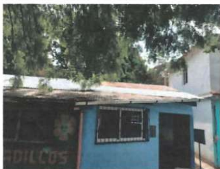
Foto1: Sustrución de cublerta de techo con lámina galvanizada, Tipo de lamina: troquelada Calibre: 26, incluye: fijaciones y sellado en traslapes.
