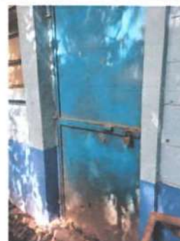
Foto 2: Mantenimiento a puerta metálica existente retiro de óxido, suciedad y pintura deteriorada; incluye cepillado, lijado, aplicación de pintura, incluyendo chapa.
